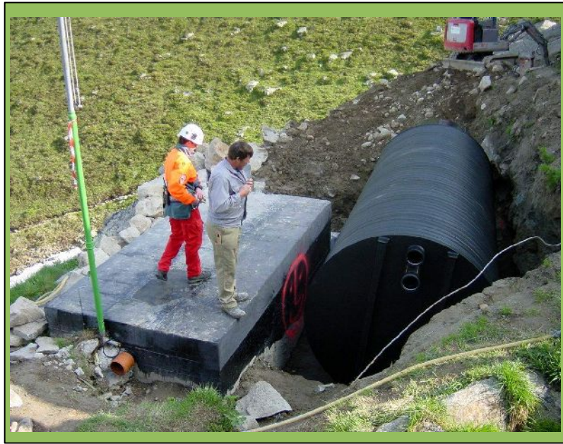
... deren Einbau neben der alten Drei-Kammer-Kläranlage. Diese dient jetzt als Turbinenraum
