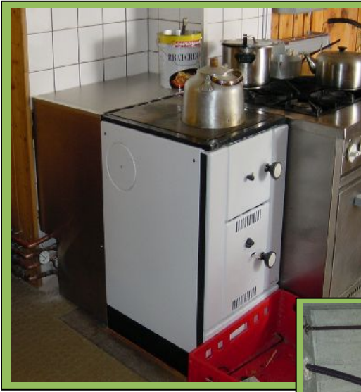
Holzpellet-Heizungsherd für Warmwasserboiler und Kochen
