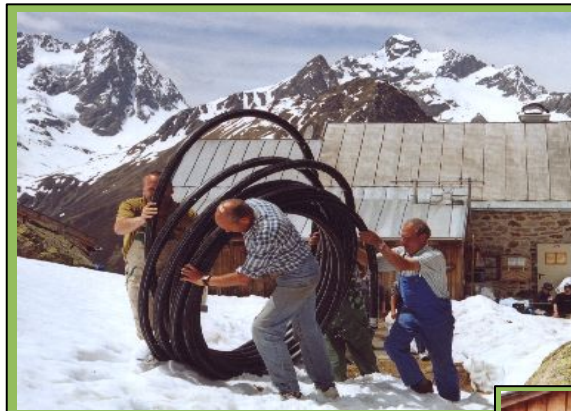
Auslegen der Druckrohrleitung
