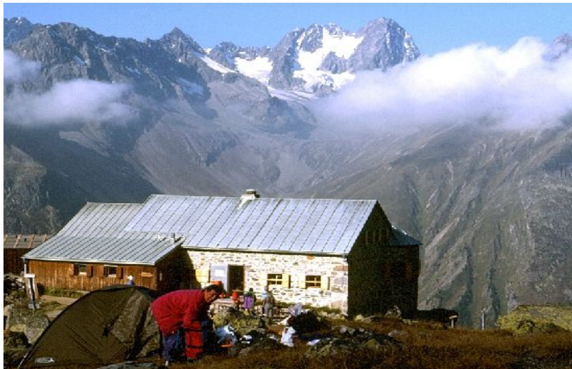
Ansicht nach der Sanierung 1981
