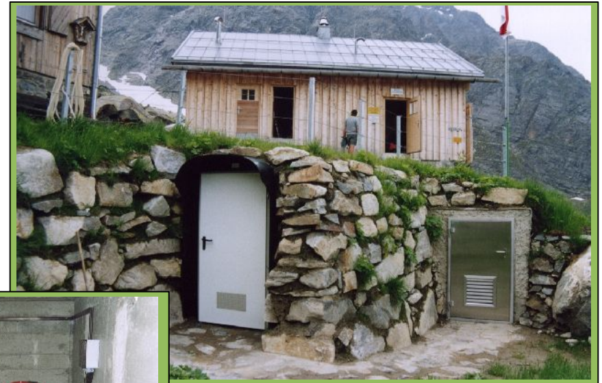
Ansicht der landschaftlich integrierten Kläranlage (links) und des Turbinenraums (rechte Tür). Dahinter die neue Winterhütte
