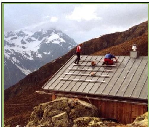
Installation der PV-Zellen auf dem Dach der Winterhütte
